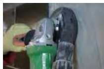
bezprašné broušení lepidla
