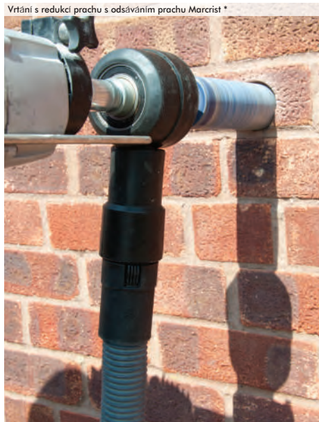
Vrtání s redukcí prachu s odsáváním prachu Marcrisť *
