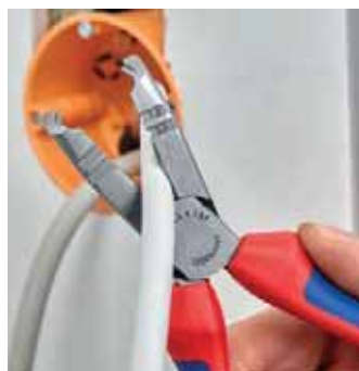
Řezání kabelu do Ø 13 mm
