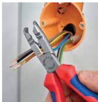
Řezání při zkracování jednotlivých vodičů
